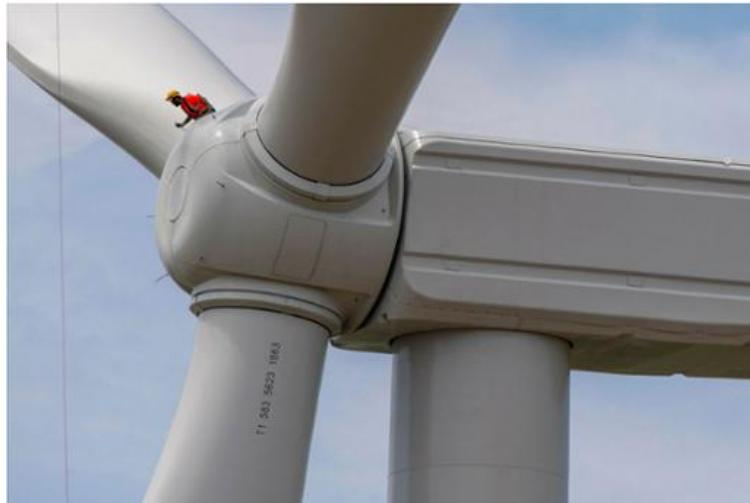
*Montage d'une éolienne, avec la fixation à la nacelle, du rotor muni de ses pales, en Ille-et-Vilaine, en juillet 2024.*
